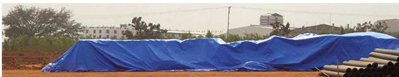
Esempio EoW coperte con geomembrana
