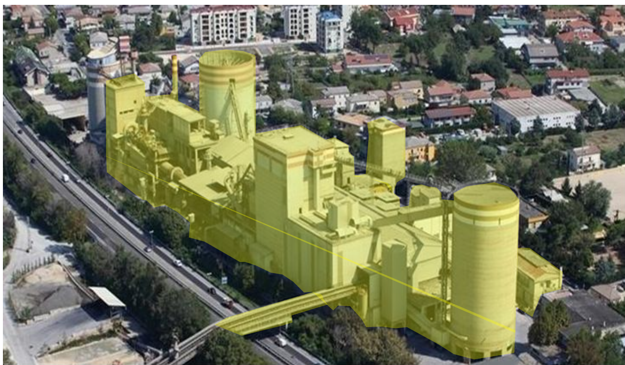
Individuazione Edificio soggetto a demolizione e produzione di rifiuti non pericolosi CER 17.09.04 da trasformare in EoW
